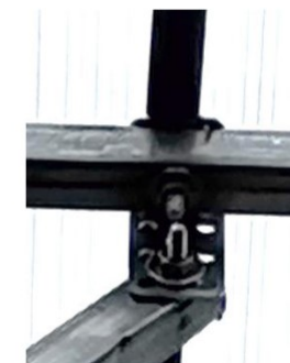
Pav. 3.4 – Viršutinės įstrižinės tvirtinimas
