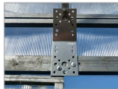
Pav. 3.4 – Viršutinės įstrižinės tvirtinimas
