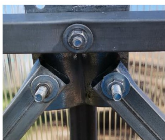
Pav. 3.2 – Šoninių įstrižainių tvirtinimas
